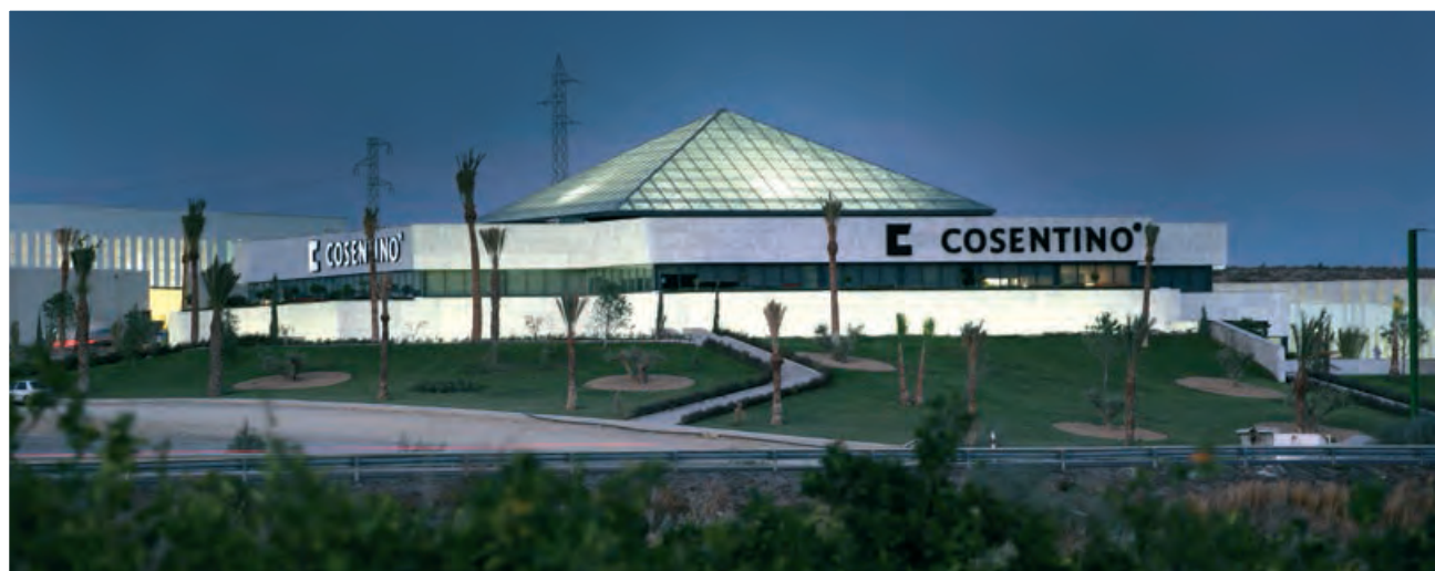
➤ Vista general del nuevo edificio de oficinas centrales del Grupo Cosentino en Cantoria. (Colección: Cosentino Group).
