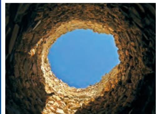
► Interior de la torreta de Cantoria, originalmente dividida interiormente en 3 plantas conformadas por forjados de madera ya desaparecidos (Foto: Antonio L. Molina Berbel).
