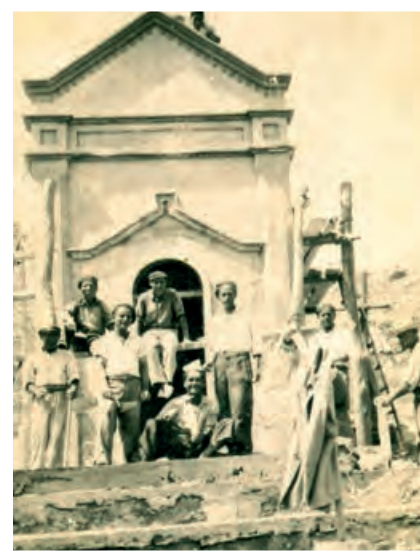
► A finales del siglo XIX se traslada el cementerio de lugar, después de la gran epidemia de cólera que asoló el valle en 1885. Se achacó que uno de sus principales focos de contagio había sido el campo santo que estaba muy cerca de la población. En esta imagen los operarios construyendo la capilla del cementerio nuevo en Tomacar. (Colección: Antonia Fernández).
