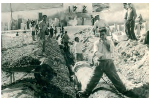
► Construcción del alcantarillado a finales de los años 50 entre la calle Romero y el Barrichuelo (calle San José). (Colección: Víctor Picazos Ramos).
