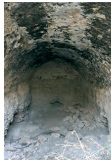
► Interior del Aljibe del Cerro de las Gachasmigas.
