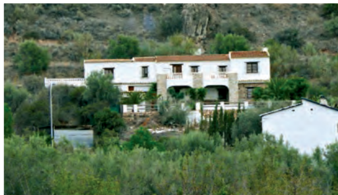
► Cortijo de la Fuente de la Hormiga. La fuente se encuentra en los sótanos de esta vivienda, que abastecía de agua potable a todos los vecinos de las cortijadas de alrededor.
