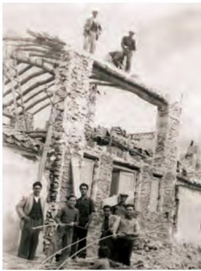
> Imagen está tomada en la calle Romero a mediados de los años 40. Se pueden apreciar los materiales y las técnicas de construcción que han predominado hasta finales de los años 60: muros de piedra, tejados de troncos y cañas. (Colección: Víctor Picazos Ramos).
