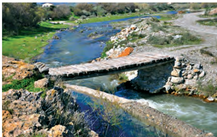
➤ Acequia que recoge a través de una boquera las aguas del río Almanzora a su paso por el Marchar. (Colección: Herminio Lucena Yáñez).
