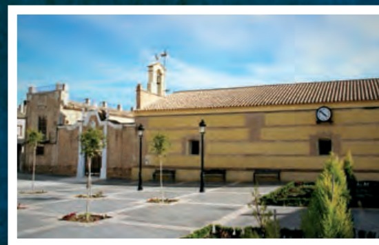
► Fachada lateral de la ermita del Palacio de Almanzora, obra del siglo XVIII.
